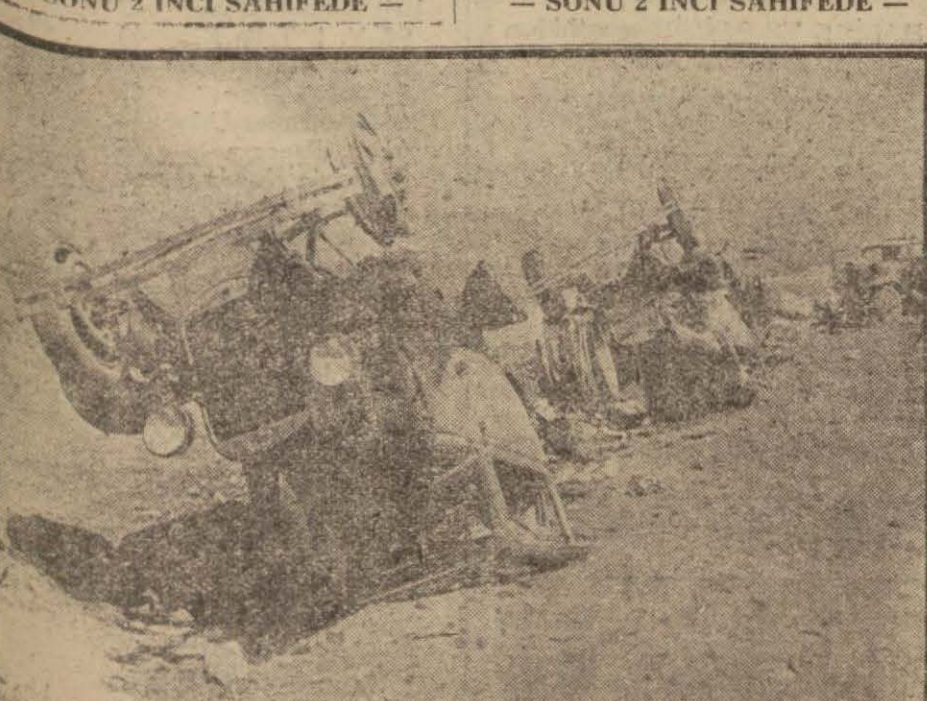
Sark cephesinde enkaz yığını haline gelmiş nakliye vasıtaları
